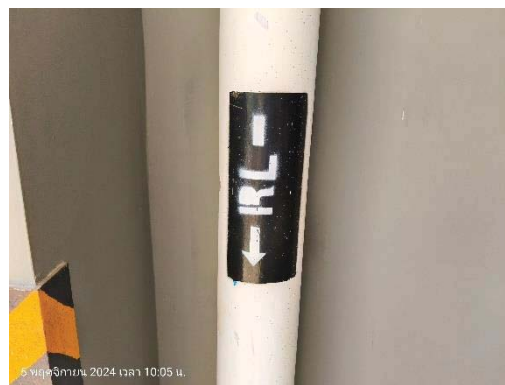
ท่อระบายน้ำฝนจากจากบนอาคาร RL
